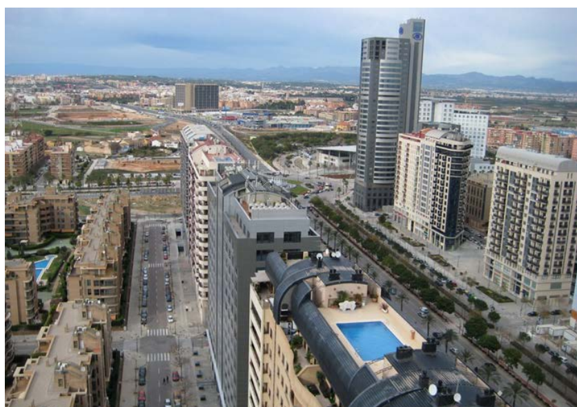
Edificio de Oficinas en Av. Cortes, Valencia Aplicación de confort
