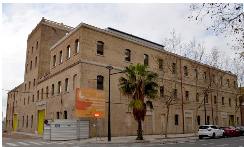
Antigua Harinera del Grao en Valencia Para instalación de inductores
