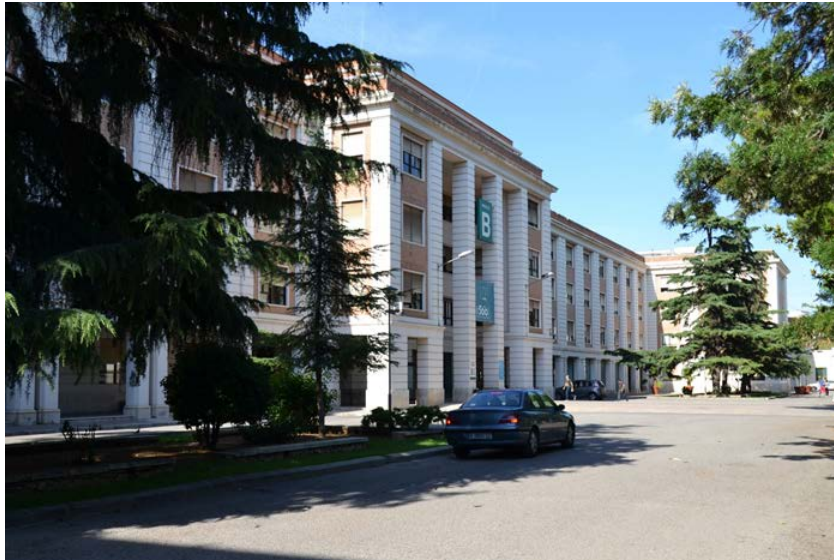
Hospital General de Valencia Aislamiento Oncológico
